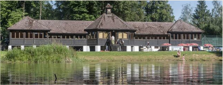
DER HISTORISCHE HOLZPAVILLON · STRANDBAD DROSENDORF
